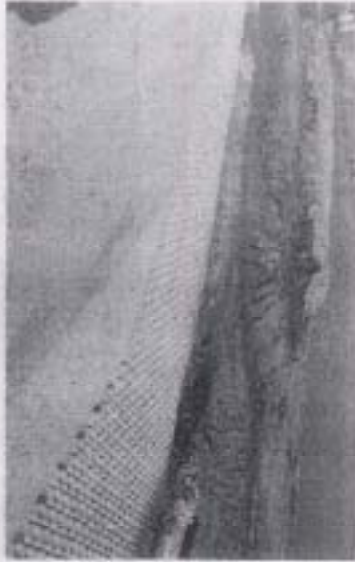
崩壊と養生と土留保壁に記されたプロックマットです。 シートのマトリクスは崩壊防止の開口部を形成する多数のコンクリートブロックで フォルダースシートを一体化したブロックシートです。
